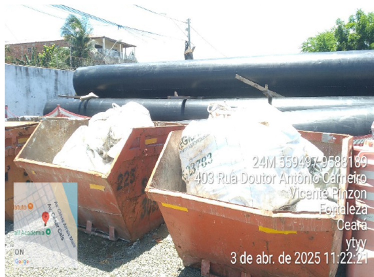
Figura 05 - Contêiner instalado no canteiro de obra do I.L. Fonte: CAGECE (2025).
