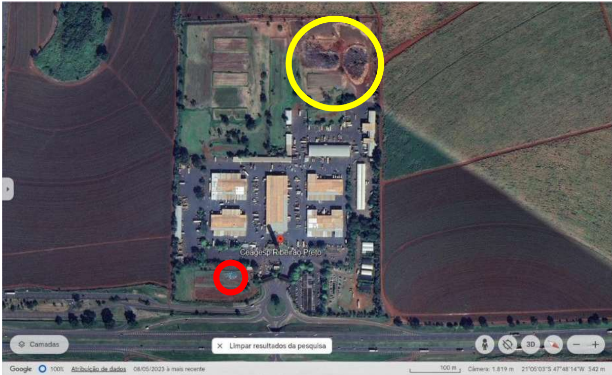
Figura 2: Vista aérea do CERIB, possibilitando identificar o “cemitério” de caixotes de madeira (círculo amarelo) e a armazenagem de fitas PET (círculo vermelho). Fonte: Google Earth.
