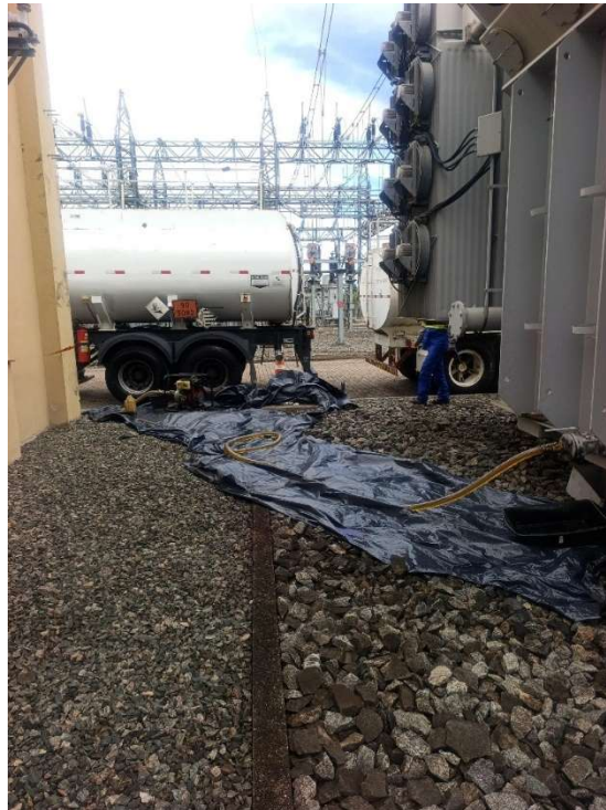
Figura 2: Transferência de óleo do transformador para o tanque do caminhão. Fonte: Copel, 2026
