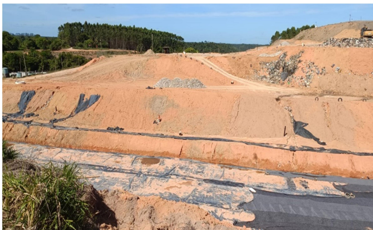
Figura 9: futuro local de aterramento.
