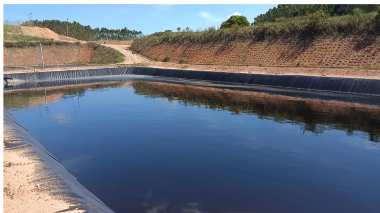
Figura 5: Lagoa de estabilização
