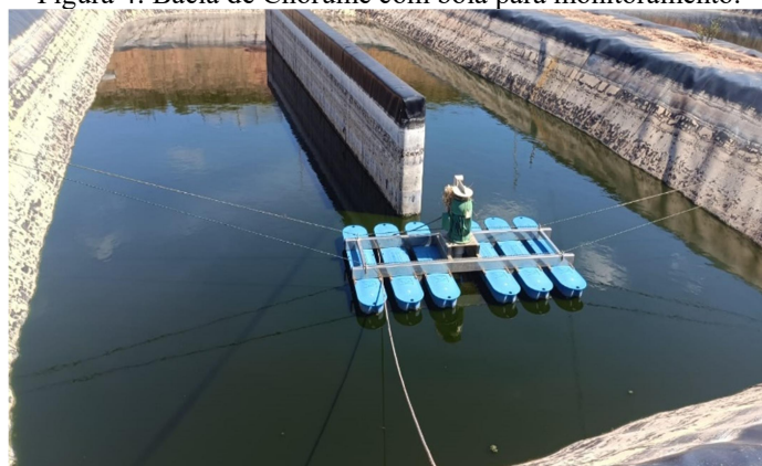
Figura 4: Bacia de Chorume com boia para monitoramento.
