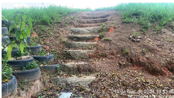
Figura 8: Escada improvisada para passagem de
