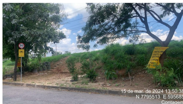
Figura 4: Área proposta para recuperação após limpeza. Fonte: Juliane Alves.
