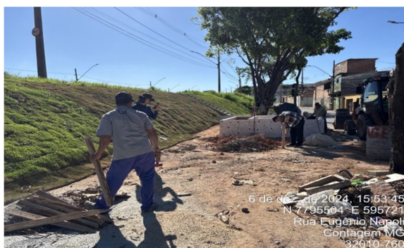
Figura 6: Execução das obras e plantios propostos. Fonte: Juliane Alves.
