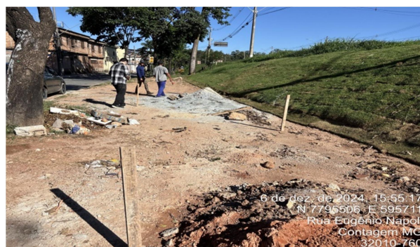
Figura 7: Execução das obras e plantios propostos. Fonte: Juliane Alves.
