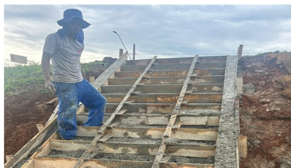
Figura 9: Execução de nova escada para passagem.
