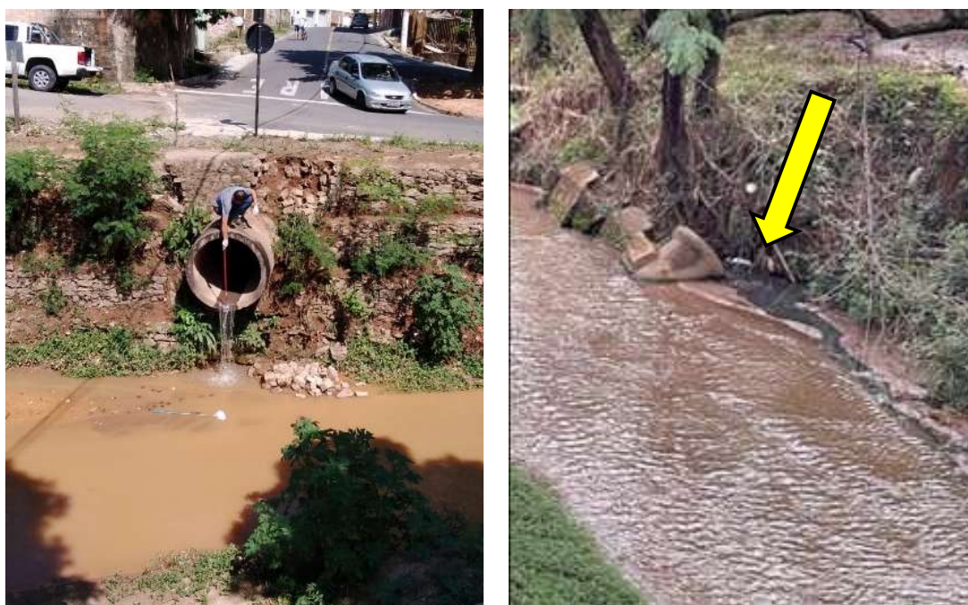
Figura 3 - Bairro Alvorada, no tubo de drenagem próximo à quadra do Alvorada (à esquerda) e tubo de drenagem próximo ao “Camelódromo”, no centro norte (à direita). Fonte: Autores (2022)
