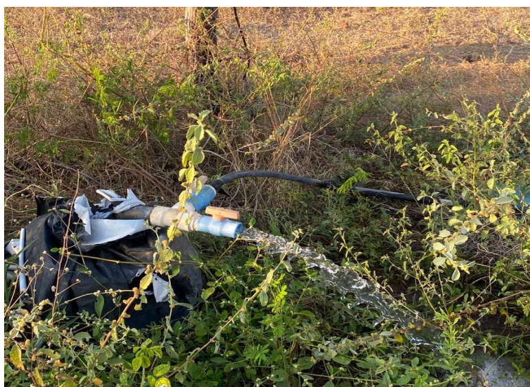
Figura 3: Poço artesiano, Sítio-Vertentes. Fonte: Autor do Trabalho.
