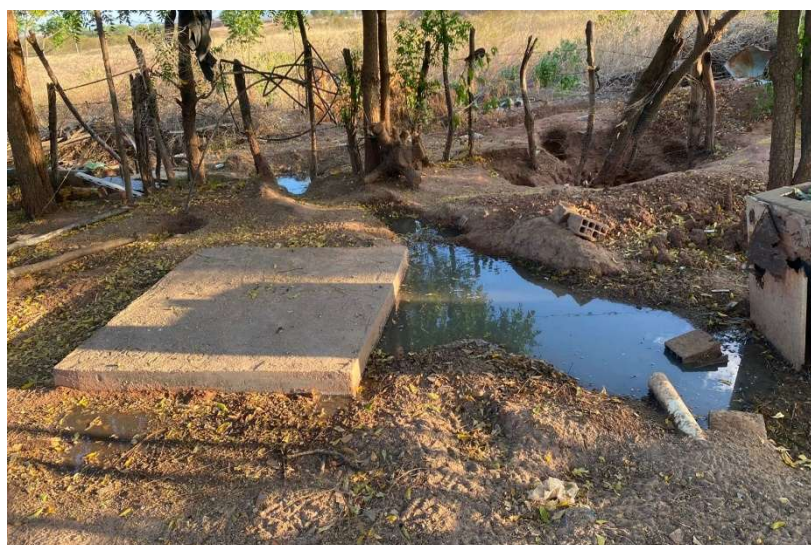
Figura 5: Fossa concretada, Sítio-Vertentes. Fonte: Autor do Trabalho.
