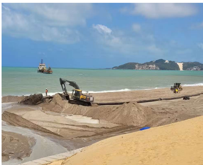
Figura 2: Obra de engorda em outubro de 2024. Fonte: GLOBO, 2025.
