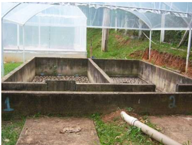
Figura 1: Leito de secagem do Lodo de Esgoto e ao fundo a estufa para secagem do Lodo, gerando o biossólido. Fonte: Autores (2025)
