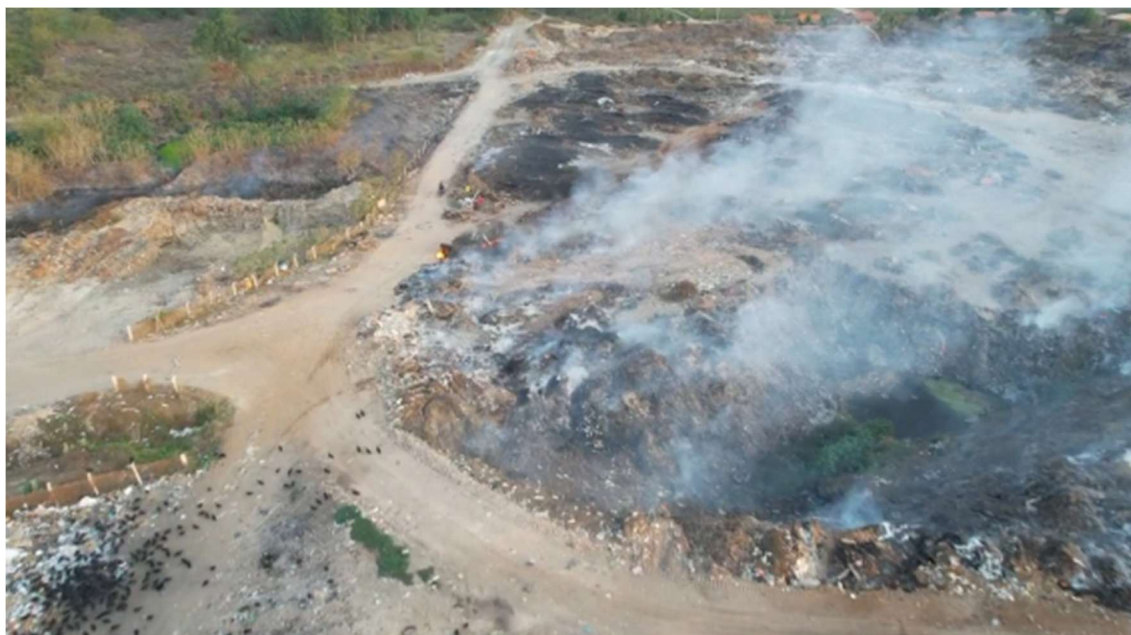
Figura 1: Incêndio no aterro sanitário de Parnaíba (PI), o terceiro registrado em agosto de 2023 (CONECTA PIAUÍ, 2023).
