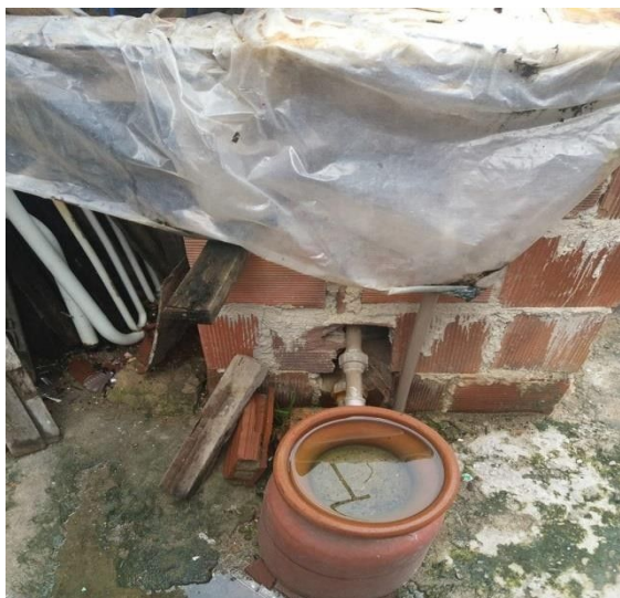
Figuras 3 e 4. Estruturas das Caixas de Bomba para os poços. Fonte: Os Autores (2020).
