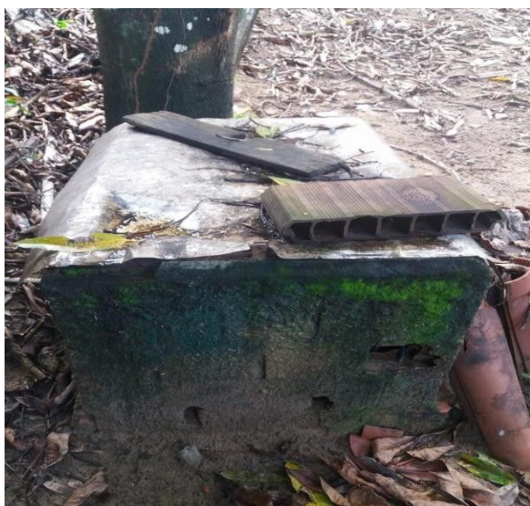
Figuras 5 e 6. Estruturas Inadequadas das Caixas de Bomba para os poços. Fonte: Os Autores (2020).
