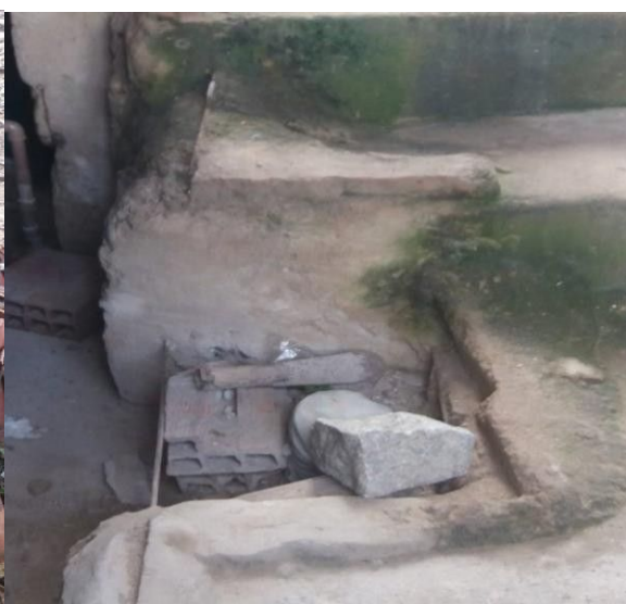
Figuras 5 e 6. Estruturas Inadequadas das Caixas de Bomba para os poços. Fonte: Os Autores (2020).
