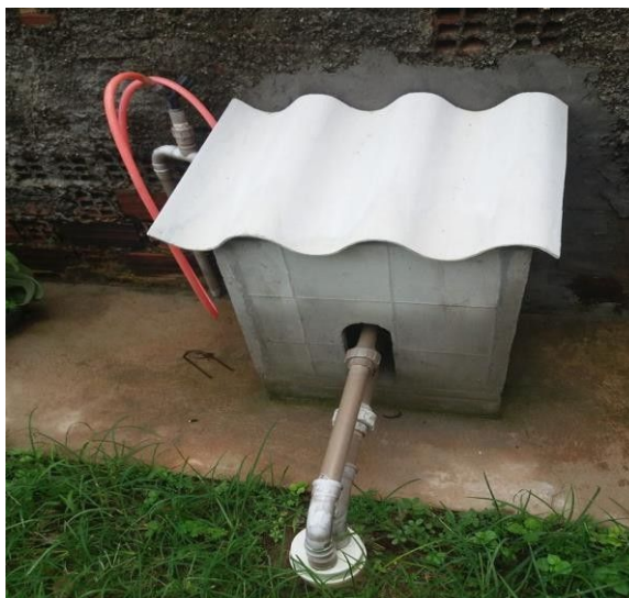
Figuras 3 e 4. Estruturas das Caixas de Bomba para os poços. Fonte: Os Autores (2020).
