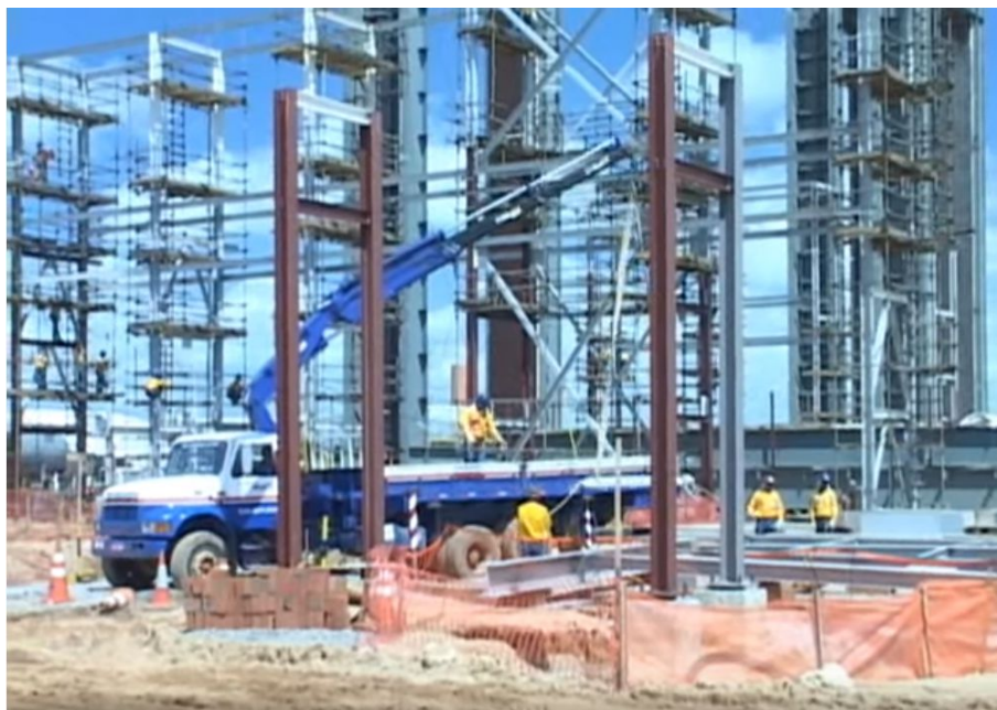
Figura 2: Construção das edificações da Usina Termelétrica Jesus Soares Pereira – UTE JSP/Termoçu. Fonte: Petrobras Youtube.com
