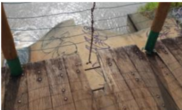
Figura 02 – Ponte no Parque Carmo Bernardes que necessita de reparos urgentemente – 2016. Fonte: Acervo pessoal.
