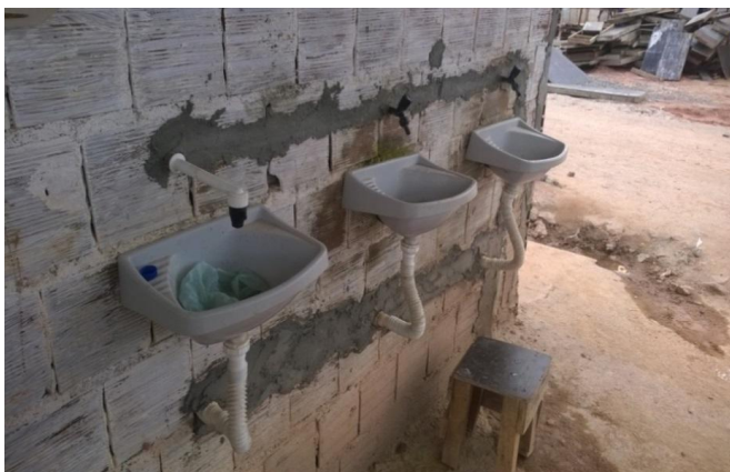
Figura 2. Torneiras na área do canteiro de obras do IFPE. Fonte: Autora do Trabalho.
