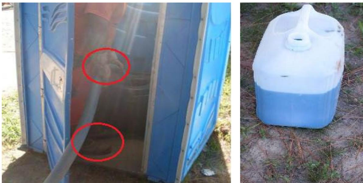
Figura 1 – A esquerda detalhe da sucção dos efluentes. Destaque: EPI's utilizados (luvas e botas). A direita recipiente com Desodorizante utilizado (sem rotulagem, infringido normas da ANVISA). Fonte: Autor do Trabalho.
