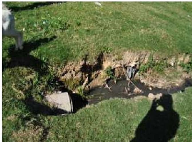
**Figura 3 – A esquerda Entrada do filtro biológico e a direita Saída de efluentes do filtro biológico, antes do recurso hídrico em que deveria ser lançado, contaminando o solo e degradando a qualidade de vida dos moradores do entorno. Fonte: Autor do trabalho.**
