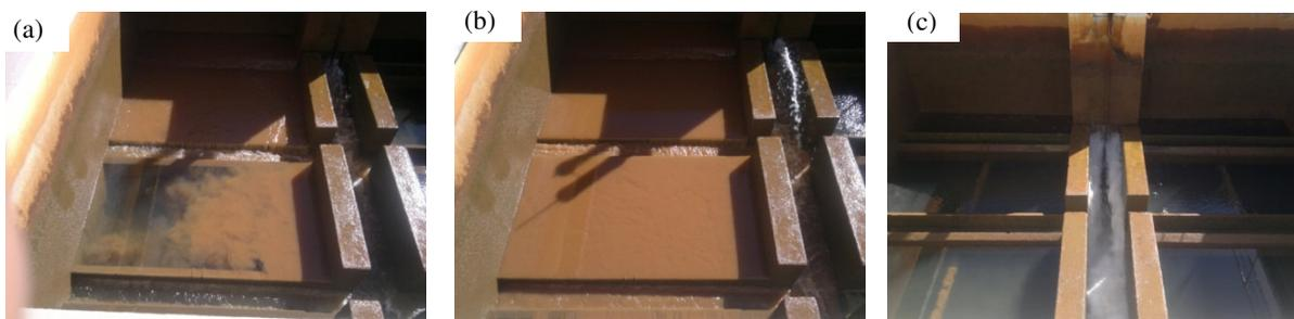
Figura 9 – (a) início da lavagem do filtro, (b) evolução do processo de lavagem e (c) etapa final da lavagem de filtros da ETA Anápolis.
