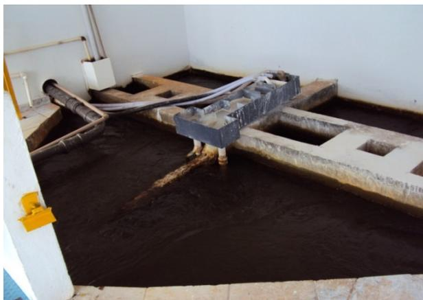
**Figura 5 - Chegada da água bruta e dosagem da cal para correção do pH.**
