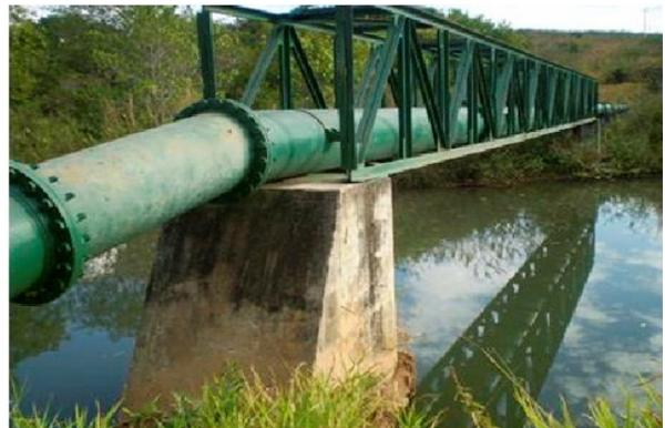
Figura 4 - Adução da água captada - Ribeirão Piancó.
