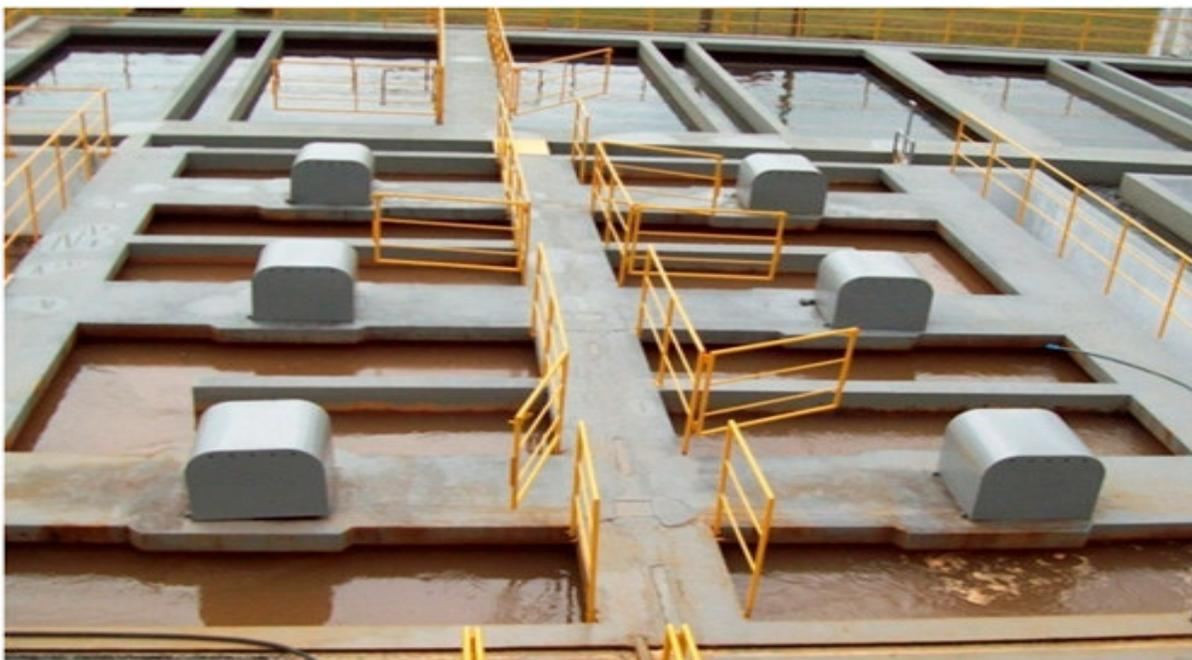
**Figura 7 - Série de floculadores com impulsores rotativos de eixo vertical e decantadores próximos aos floculadores, ETA Anápolis/GO.**
