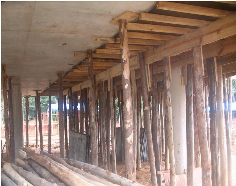
Figura 2 – Fôrma da laje com chapa de madeirite. Fonte: Projeto de residência - Steves Rocha<sup>1</sup>
