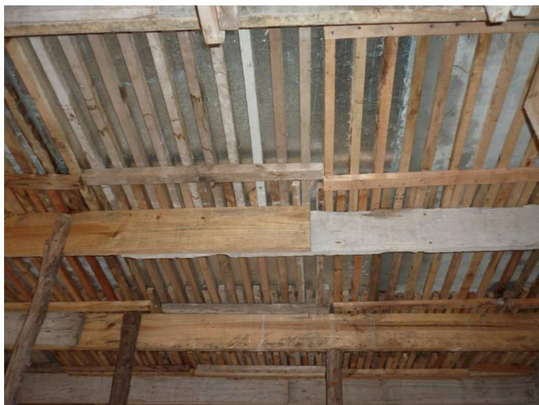
Figura 3 – Fôrma da laje com chapa galvanizada. Fonte: Autor do trabalho.
