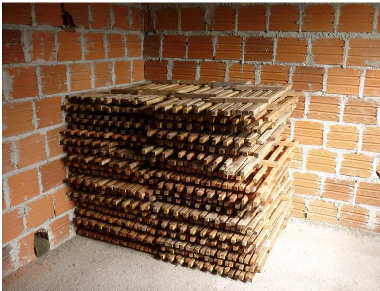
Figura 5 – Forma de acondicionamento da fôrma para laje. Fonte: Autor do trabalho.
