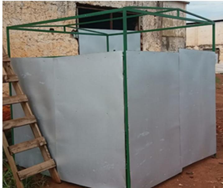
**Figura 2: Estrutura metálica utilizada para a fabricação do PEV. Fonte: Autoras**
