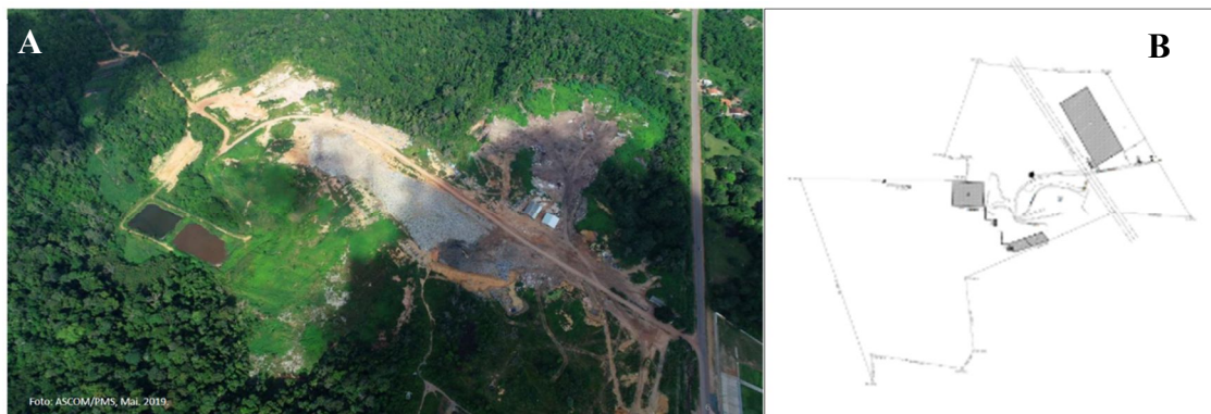
Figura 1. Localização do Aterro Controlado Municipal do Perema no município de Santarém - PA. Fonte: Dados Fornecidos pela PMS.
