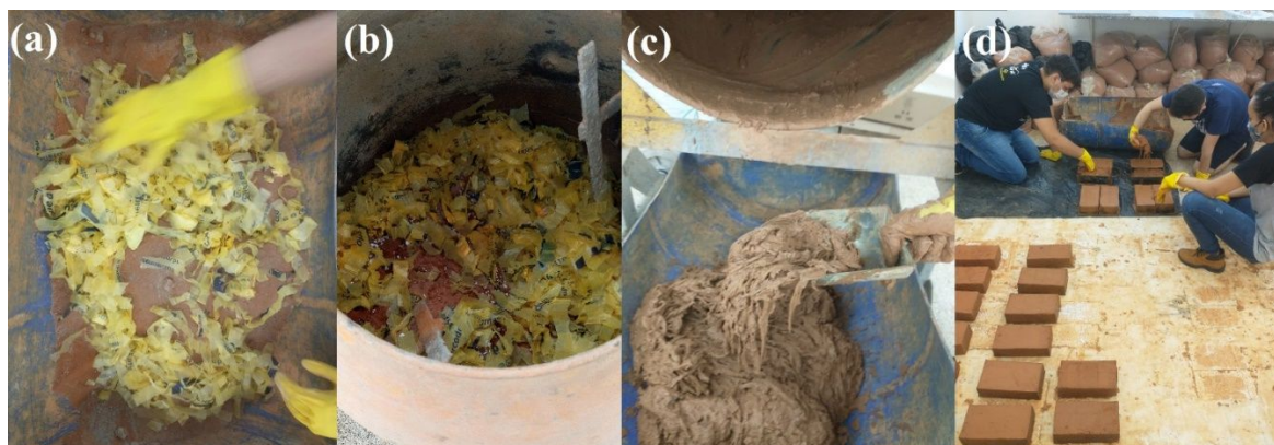
Figura 2: Etapas do procedimento de confecção dos blocos: (a) mistura prévia de solo, cimento e fibra; (b) mistura dos materiais na betoneira; (c) aspecto da mistura para moldagem; (d) moldagem dos blocos.
