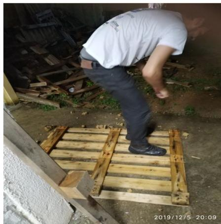
**Figura 4: Desmonte dos pallets para execução da estrutura do telhado. Fonte: Autores (2019).**
