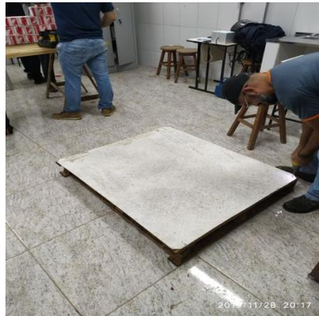
**Figura 3: Preparação estrutura da casa com pallet e placa de material reciclável. Fonte: Autores (2019).**
