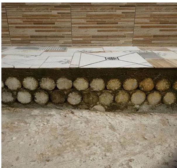
**Figura 3: Reaproveitamento de corpos de prova de concreto em calçadas. Fonte: Construção Civil – Teoria e Prática.**
