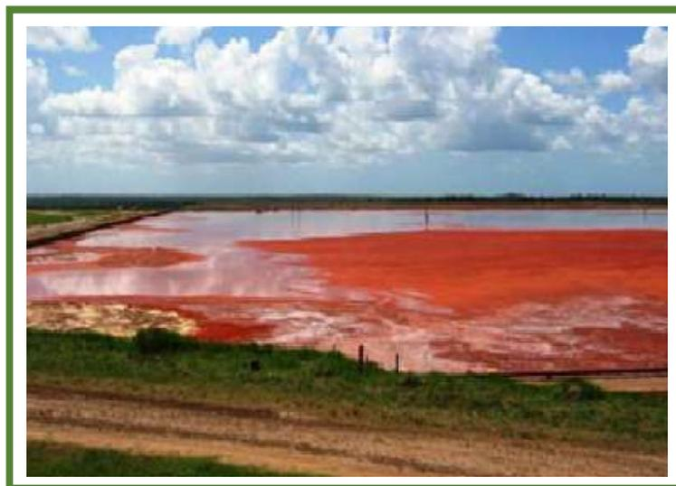
**Figura 4: Lagoa de rejeito na área da mineradora. Fonte: Garcia, 2012.**
