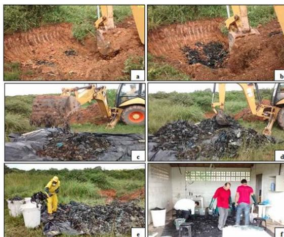
**Figura 1 - Procedimento de escavação/mineração dos resíduos aterrados: (a) remoção da cobertura vegetal; (b) remoção da camada de cobertura; (c) coleta do resíduo aterrado, (d) quartejamento do resíduo, (e) amostragem do resíduo e (f) caracterização gravimétrica. Fonte: Extraído de HOLANDA (2016)**
