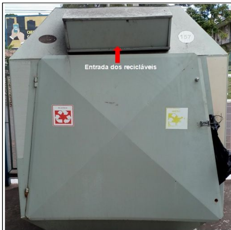
Figura 3: A abertura do PEV, por onde a população deposita os materiais recicláveis.
