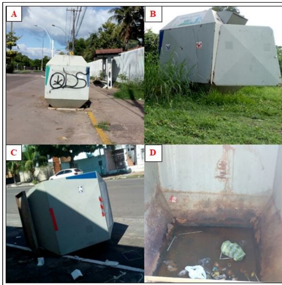
Figura 2: A imagem A apresenta um PEV instalado próximo a um ponto de ônibus e uma escola. O mesmo está depredado e exalando mau odor, gerando incômodo aos usuários do serviço de transporte coletivo. O PEV-B está cercado por vegetação em terreno baldio, dificultando o acesso do cidadão para a deposição do material reciclável. O PEV-C instalado em uma região central da cidade, foi tombado pelo próprio órgão responsável pela instalação. O PEV-D mostra o acúmulo de água parada, o que pode contribuir para a proliferação do mosquito Aedes aegypti (vetor de um conjunto de graves doenças), além de uma variedade de resíduos urbanos.
