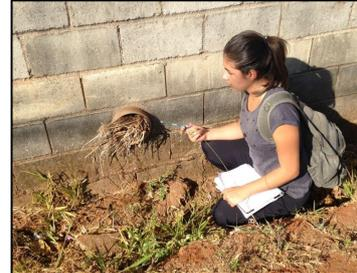
Figuras 13, 14 e 15 - Ponto 8: Muro que delimita o campus com arruamento e faixa com gramado. Detalhe da calçada em processo de degradação. Detalhe para a presença dos pontos de escape da água no muro, com a presença de sedimentos e do canal erosivo.
