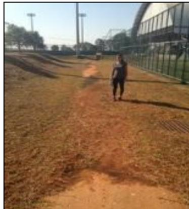
Figura 18- Ponto 10. Detalhe para os sedimentos depositados sobre a pista e que provavelmente serão carreados posteriormente, no período chuvoso. Foto: Júlio Rubin, 19/08/2017.
