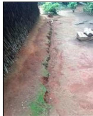
Figuras 23, 24 e 25 - Ponto 14. Sistema de captação das águas da nascente. Erosão próximo a habitações da aldeia indígena devido ao escoamento pluvial. Sulco com largura média de 12cm e profundidade média de 10cm. Foto: Sindiléia Andrade, 2017.
