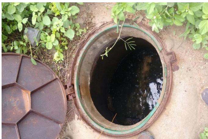
**Figura 2: Poço de visita que recebe o lixiviado das células do ASCG.**
