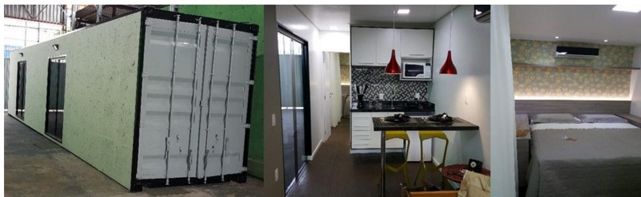
**Figura 3: Residência em container marítimo. Fonte: Sader Engenharia Ltda.**
