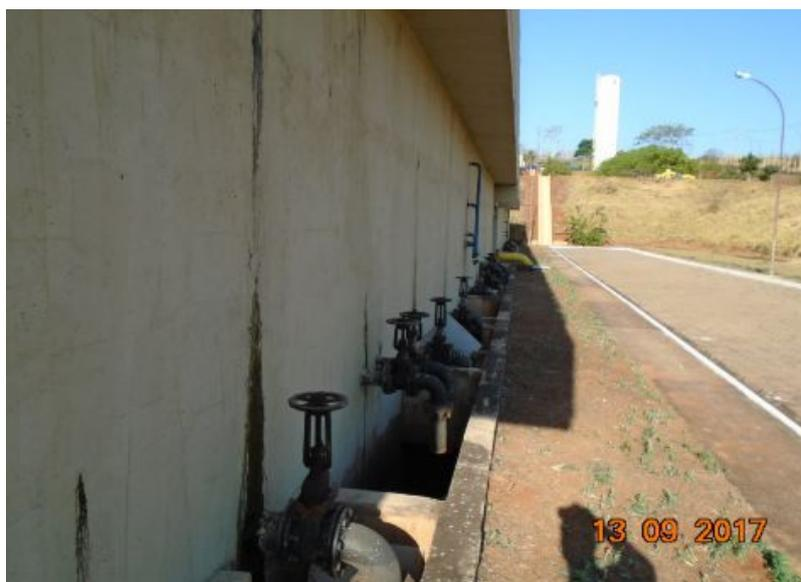
**Figura 2: Local de Remoção do LETE em reator UASB. Fonte: Autores, 2017.**
