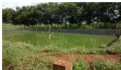
Figura 7 - Lagoa para armazenamento do percolato. Autor do trabalho.
