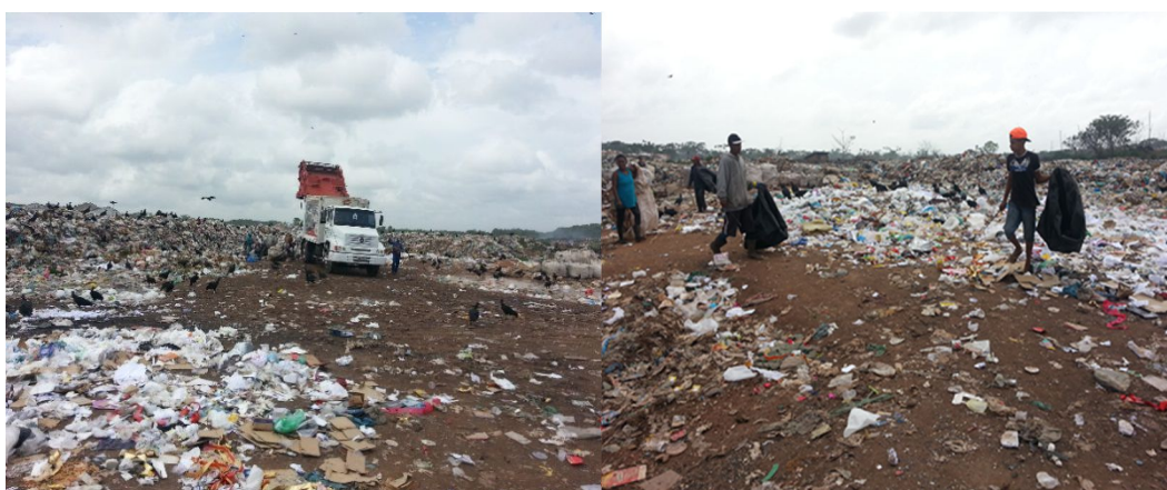
Figura 03: Destino final de RSU em Castanhal, classificado como lixão a céu aberto. Aspecto desordenado, ausência de compactação e de cobertura regular da massa de lixo, presença de catadores. Fonte: Do autor, 2016.
