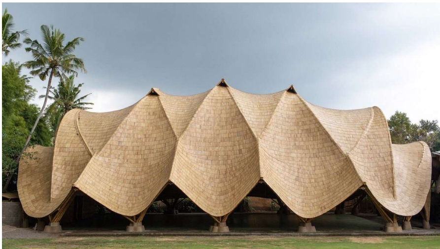
Figura 03: Telhado com estrutura de bambu.
