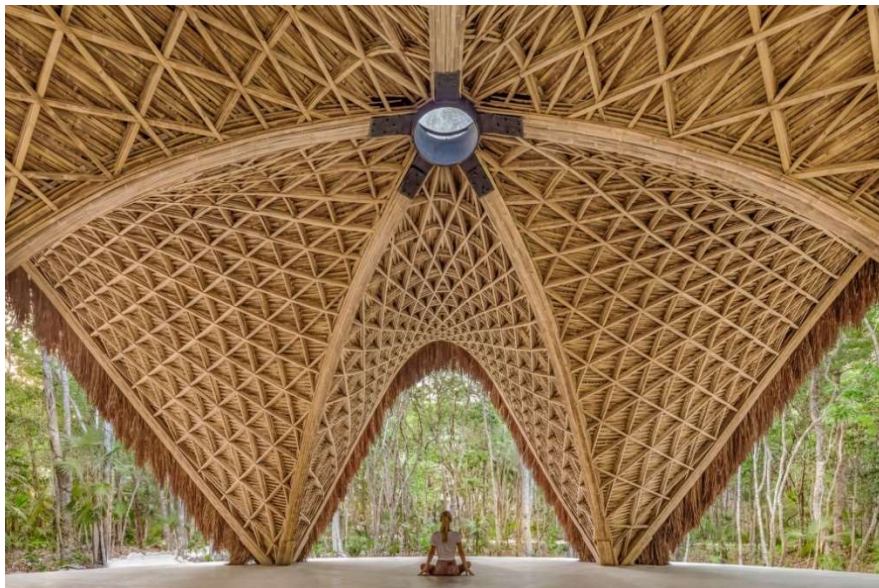
Figura 02: Estrutura com componentes de Bambu.
