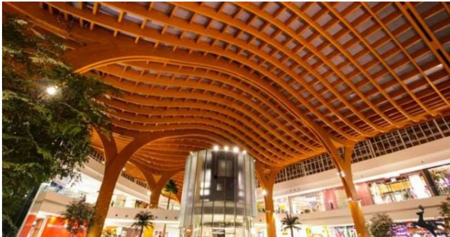
Figura 01: Estrutura de Madeira.
