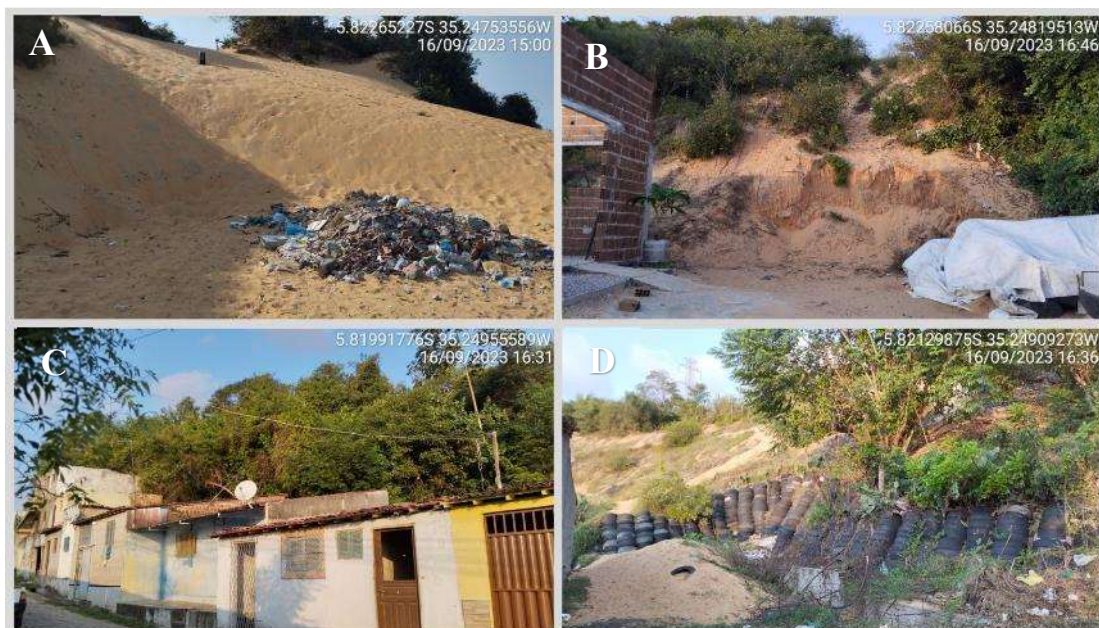
Figura 5: Aspectos e impactos ambientais na Duna 9. A – Retirada de areia e deposição de resíduos no sopé da duna; B – Retirada de sedimentos para construção; C – Casas construídas na encosta da duna; D – Utilização de pneus como barreira de contenção. Fonte: Autor do Trabalho
