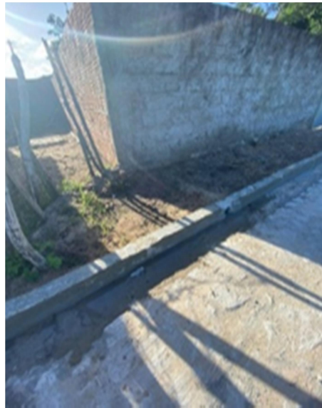
Figura 2: Descarte inadequado de efluente doméstico. Fonte: Autores do Trabalho.
