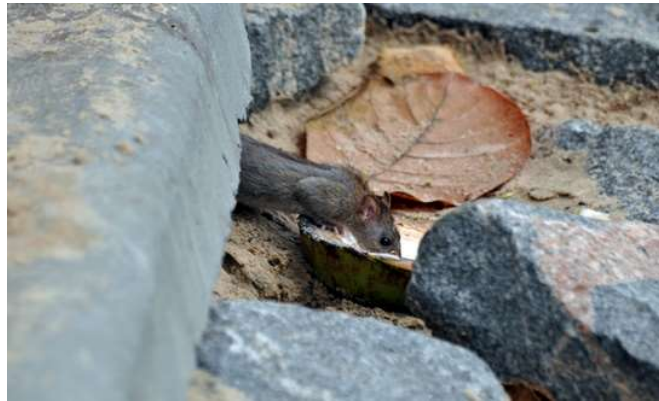
Figura 03 – Obra de contenção (enrocamento) sendo abrigo de roedores transmissores de doenças. Fonte: Uol Notícias
