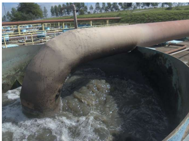
Figura 1: Vista de ponto de emissão de gás sulfídrico em reator UASB. Fonte: ACP n° 5208124-27.2019.8.13.0024 (TJMG).
