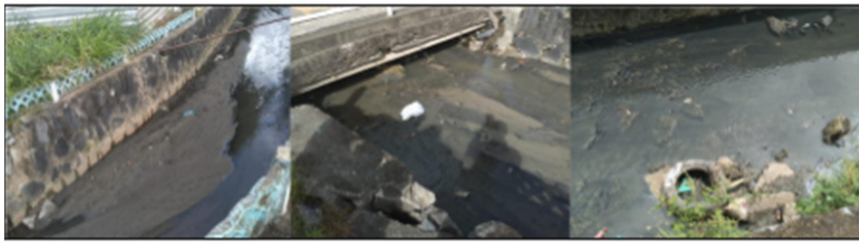
Figura 7 - Assoreamento do canal. Fonte: Autores, 2023.
