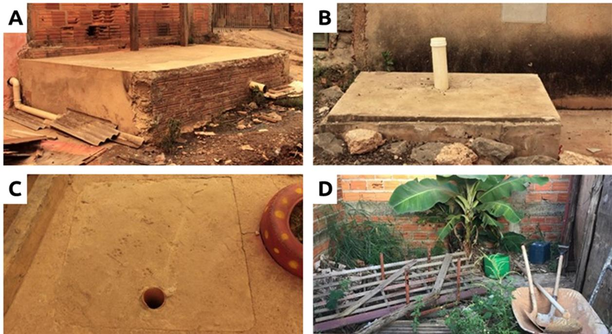
**Figura 5: Tanques Sêpticos individuais – A: Tanque Sêptico com despejo na via; B: Tanque Sêptico com tubulação de inspeção e tampa; C: Tanque Sêptico com tubulação de inspeção no nível do solo; D: Tanque Sêptico com bananeira. Fonte: Arquivo pessoal (2019).**
