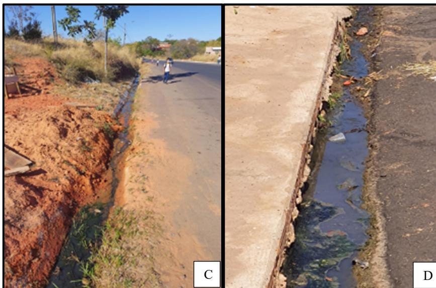
**Figura 4 (C e D). Lançamento do esgoto na baixada.**
