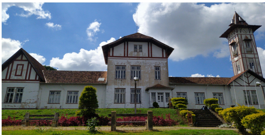
Figura 02 – Fachada do prédio Sede do IF Sudeste MG - campus Barbacena. Fonte: dados da pesquisa, 2023.
