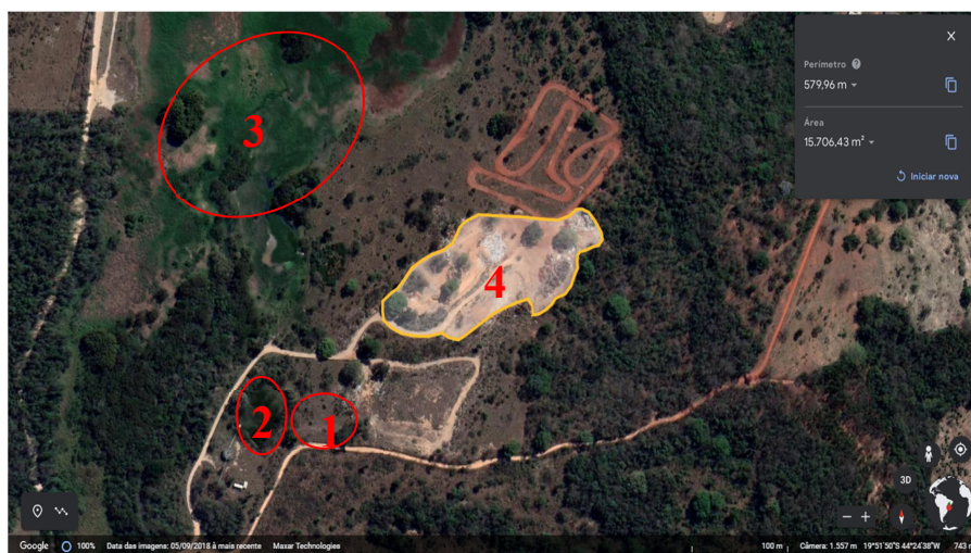
Figura 14: Aterro controlado 2010 (1), lagoa de decantação (2), barragem de água (3) e aterro controlado 2018 (4)
