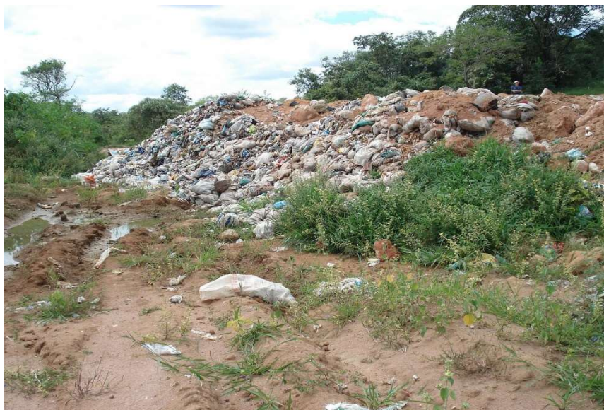
Figura 10: Talude (3,0 m) de resíduos parcialmente cobertos no ano de 2010. Fonte: Lemos C. F, 2010.
