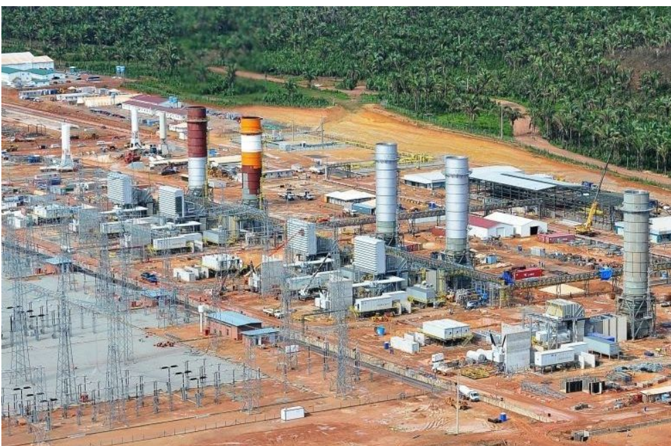
Figura 4: Usina Termoeletrica Parnaíba I, Maranhão. Fonte: Eneva, 2015.
