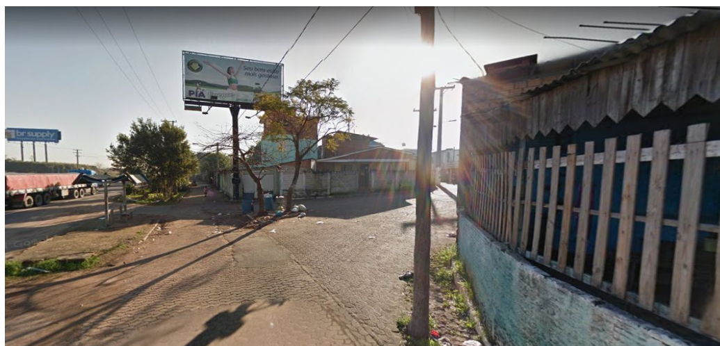
Figura 5: Entrada da Vila da Pedreira, Esteio/RS, único acesso pela BR-116.
