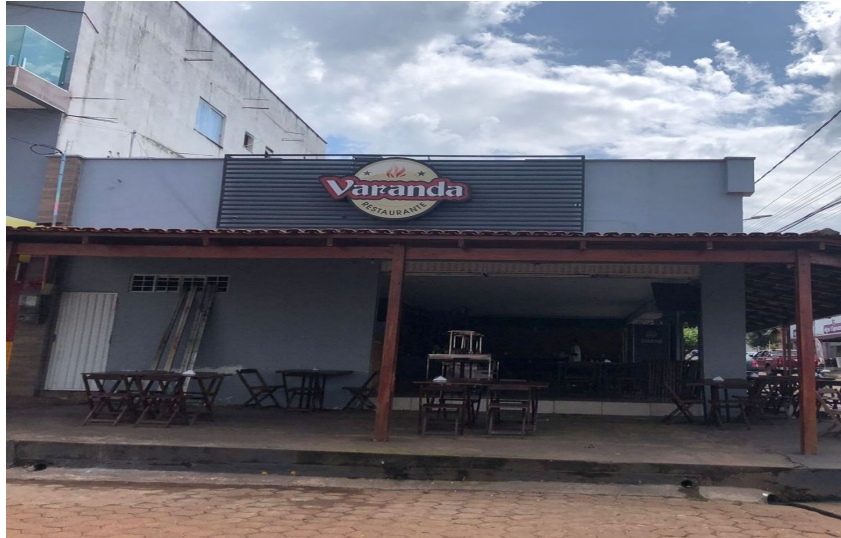
Figura 1: Vista frontal do Restaurante Varanda. Fonte: Autores do Trabalho.
