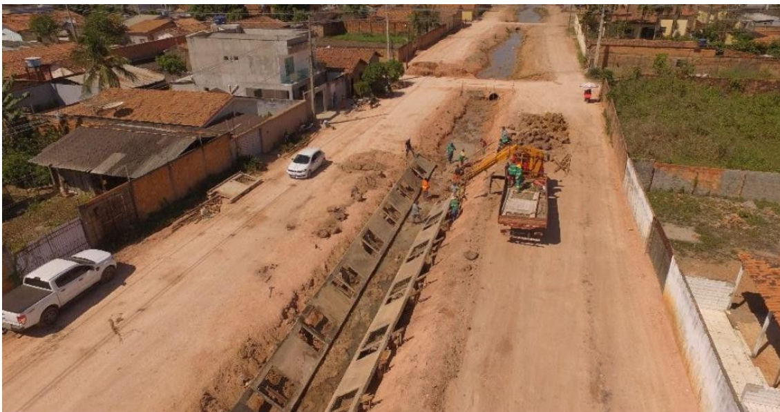
Figura 2: Trecho do canal em obras. Fonte: Autor do Trabalho.
