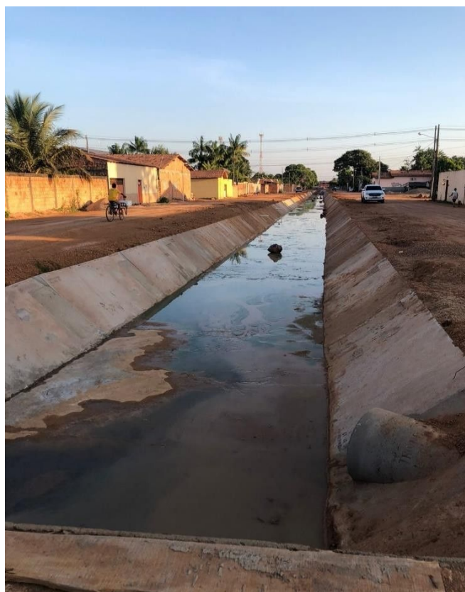
Figura 3: Trecho do canal concluído. Fonte: Autor do Trabalho.
