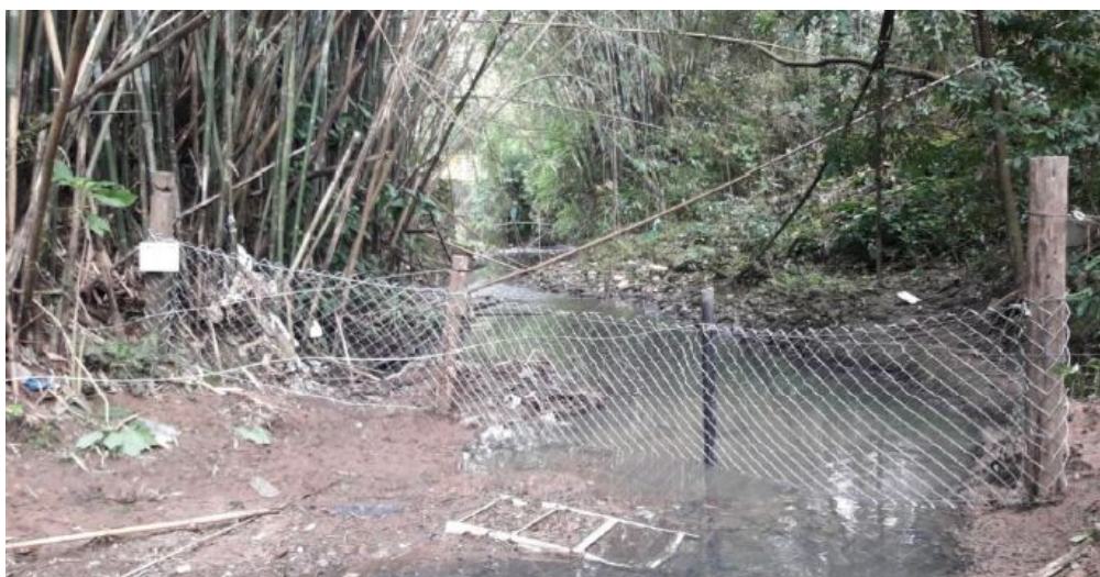
Figura 2: Barreira coletora de resíduos na bacia do Arroio Cancela. Fonte: Autor do trabalho.
