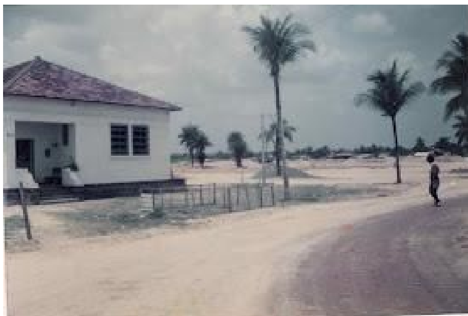
Figura 1: Registro do Casarão, uma das primeiras construções na Comunidade. Fonte: Autor do Trabalho.
