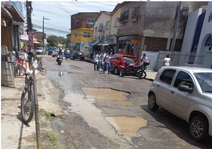
Figura 4: Vazamentos visíveis - Cratera na avenida principal da comunidade Roda de Fogo: Av. Bicentenário da Revolução Francesa, em frente ao N.º. 40 B. Fonte: Autor do Trabalho.
