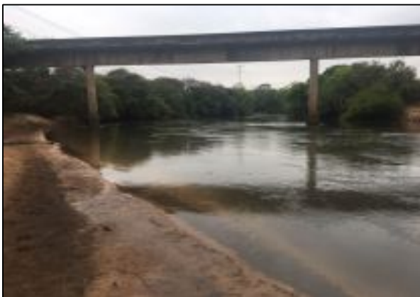
Figura 12- estrutura da ponte sobre o rio Verde que deve ser direita objeto de monitoramento constante.
