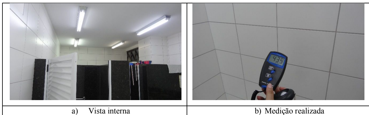
Figura 5: Sanitário feminino do 2º pavimento. Fonte: Autor do Trabalho.
