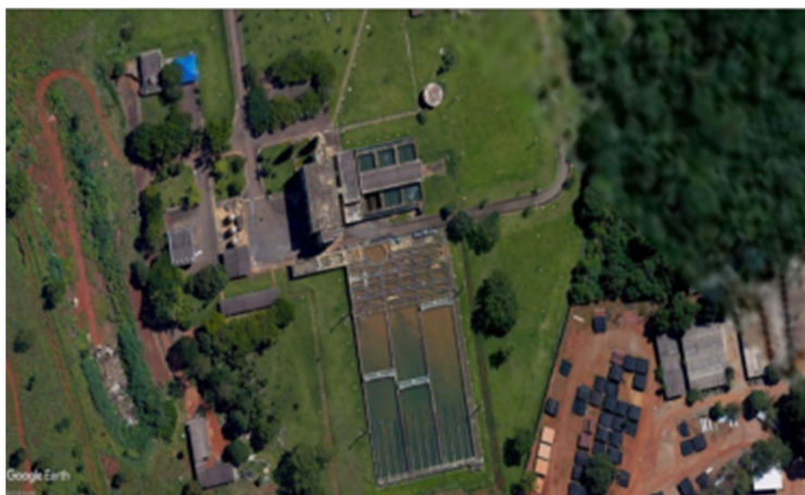
Figura 11- Local da casa de maquinas, canalização de saída dutos. Fonte: Google Earth (2014).
